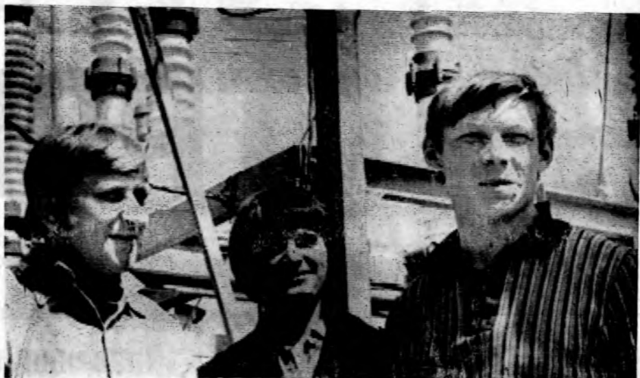
Электроснабжение — ответственная часть работы по вводу первой очереди завода. Понимая это, отлично трудятся рабочие энергоучастка А. ТЕПЛИЦЫН, И. ШИБАЛОВ, И. ПОЗДЕЕВ (на снимке).
